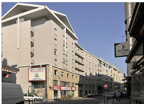
Logements étudiants - quartier Guillotière © Agence d'urbanisme de Lyon 2009
