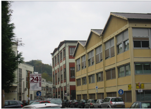
Bâti ancien industriel, Gorge de Loup © Agence d'urbanisme 2008
