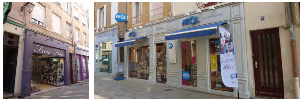
A gauche: une devanture qui «dématérialise» le rez-de-chaussée de l'édifice.
