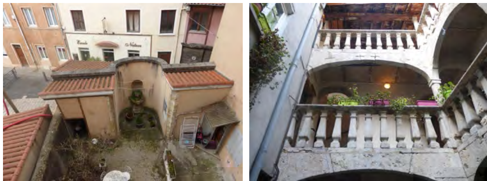
La préservation et restauration des éléments remarquables répertoriés (cours, fontaines, compositions, etc.) ou non est nécessaire : ils sont une composante de l'identité locale.
