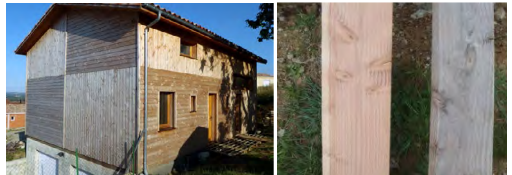
Le vieillissement du douglas : à gauche, un an après la pose. À droite, planche neuve et trois ans après. Le mélèze est un bois devenant également gris avec le temps.
