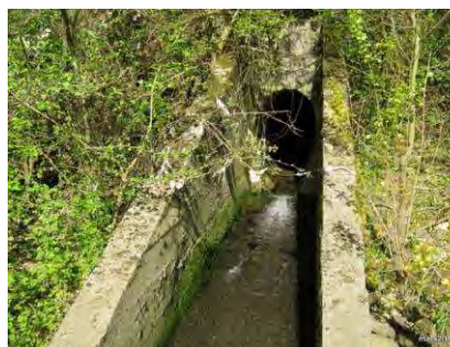
Ruisseau des Charbottes : à l'aval
