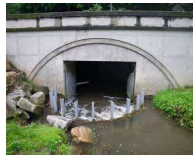
Ruisseau de Rocheardon : ouvrage
